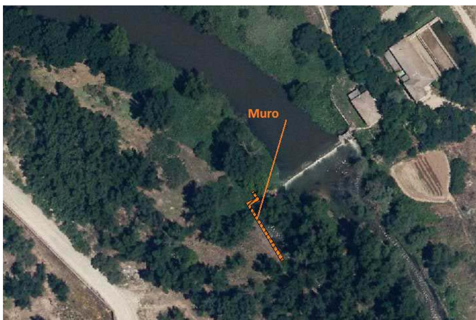
Localización del muro de acompañamiento del azud de la margen derecha
