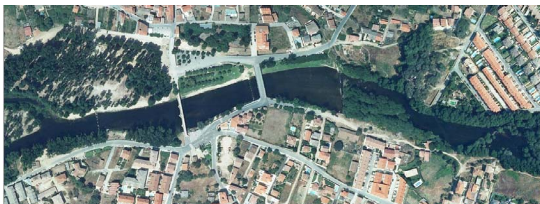
Presencia de numerosas barreras transversales.
