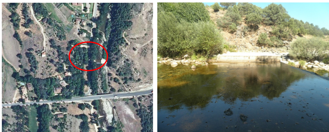
Detalle de la ubicación de la estación de aforos
